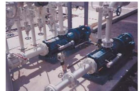
Насосы СЕН с электромагнитными муфтами для опорожнения вагонов-цистерн
