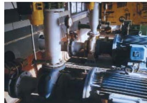
Насосы **SIHI<sup>ISOchem</sup>** с электромагнитными муфтами для транспортировки загрязненных сточных вод
